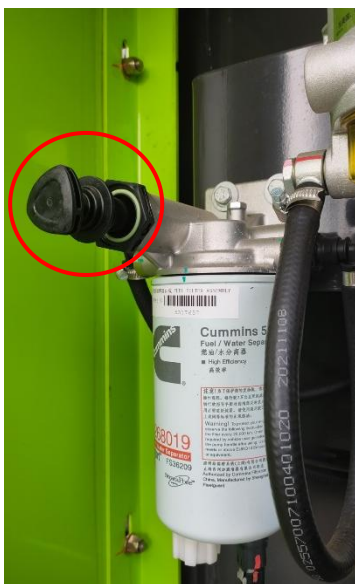
Ábra 5-20. kézi szivattyú az üzemanyagszűrőhöz
