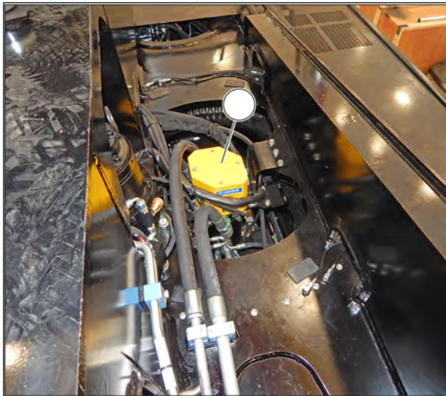
Ábra 307: A forgó elektromos kollektor távadó gyűrűinek ellenőrzése és tisztítása
