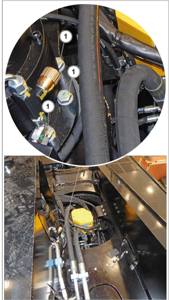
Ábra 159: Forgásreduktor rögzítőcsavar meghúzásának ellenőrzése
