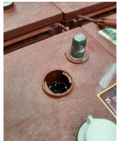
Megfelelő elektrolit szint: Az elektrolit szint éppen eléri a betöltő nyílás alját,
